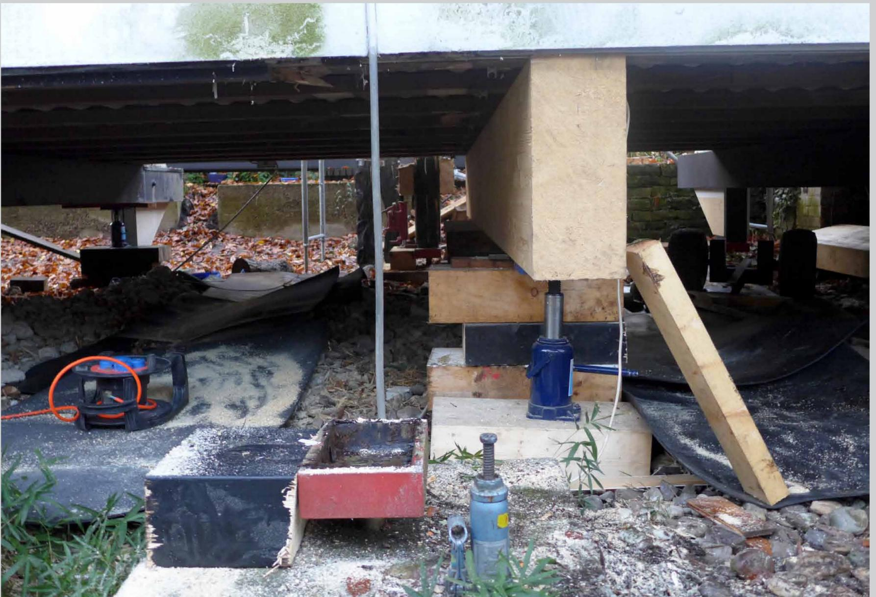
Ein Leimholzträger wurde für die Abfangung des Erdgeschosses hergestellt. Bewegt wurde er mit einem dafür angefertigten Wagen.
