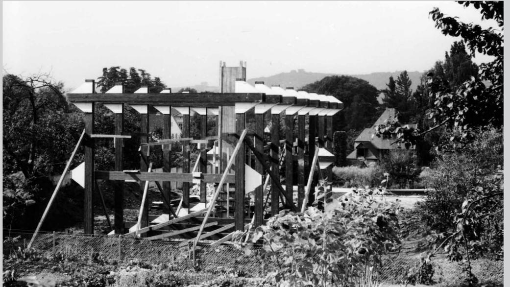
Aufstellen der Tragkonstruktion aus Stielen und Doppelzangen
