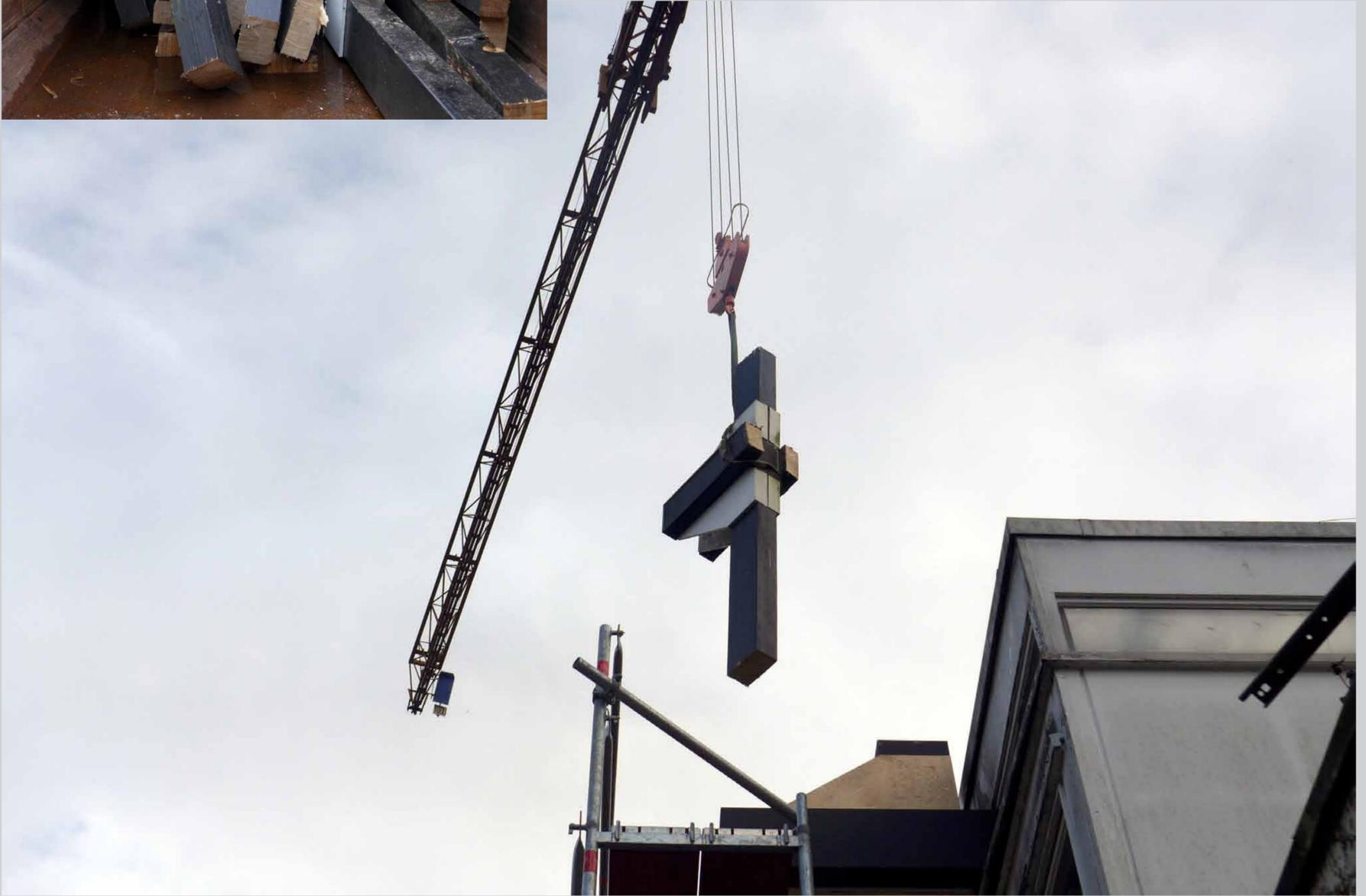
Große Teile des alten Holztragwerks werden mit Hilfe eines Krans angehoben und in einem Container abgelegt. Die neuen Balken werden an die Einbaustellen herangeführt und von innen von Hand eingezogen.
