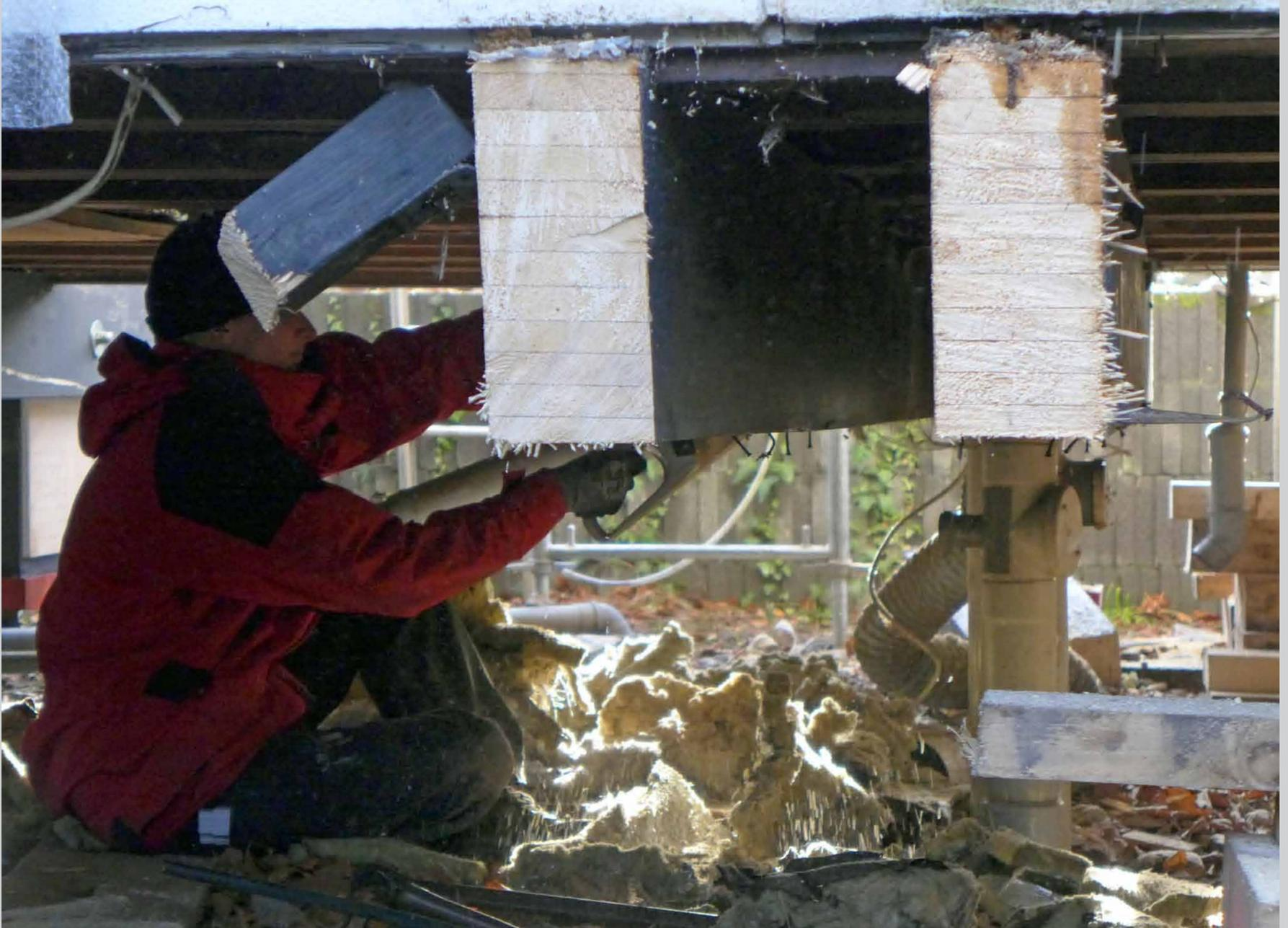
Das Tragwerk wird Achse für Achse erneuert. Das Haus wird etagenweise vom Boden bis zum Dach abgestützt und ausgesteift.
